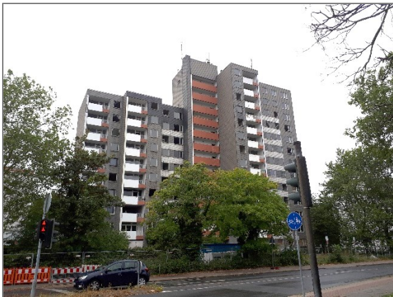
Abbildung 15: Leerstehendes und sanierungs- oder abrisssbedürftiges Wohngebäude am Vluynner Nordring
