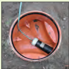
Abb. rechts Vorbereitung der Druckprüfung im Revisionsschacht
