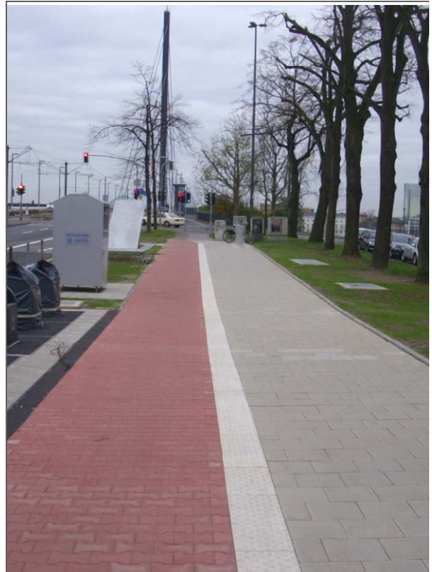
Bild 4-4: Getrennter Fuß- und Radweg
