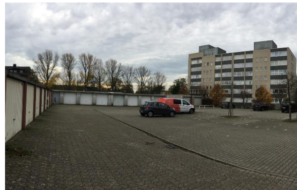
Abb. 30: Wohnobjekt Poststraße (Neukirchen): Handlungsbedarf in Form eines überdimensionierten Garagenhofs
