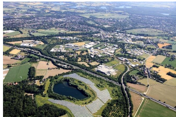
Abb. 146: ENNI Solarpark Mühlenfeld
