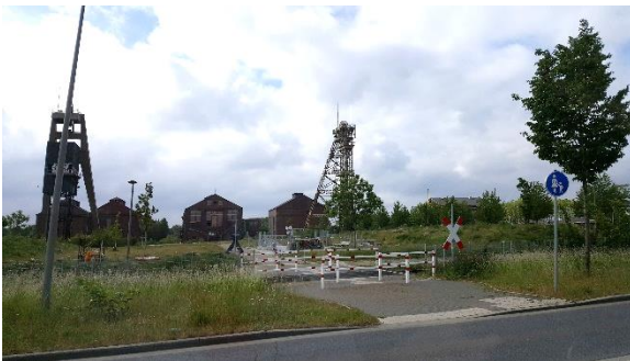
Abb. 24: Derzeit ungenutzte Bahntrasse im Bereich der ehemaligen Zeche Niederberg
